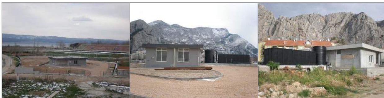
Pogled sa sjeverne strane
